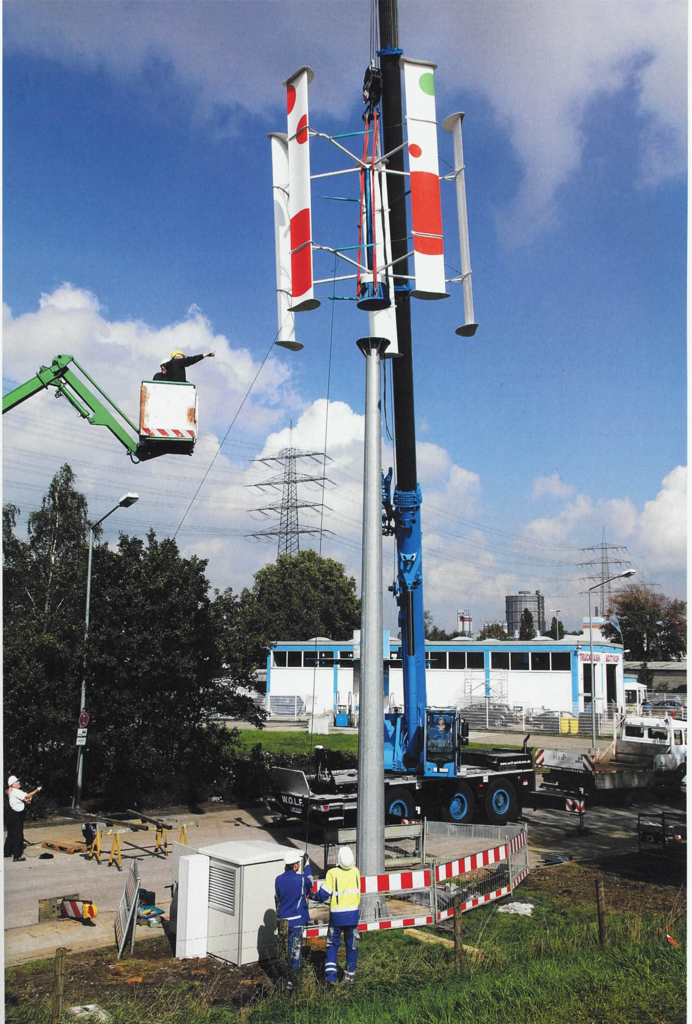
Querdreher: Die neue Testanlage des Stromversorgers Emscher-Lippe-Energie in Bottrop hat eine Leistung von fünf Kilowatt.
